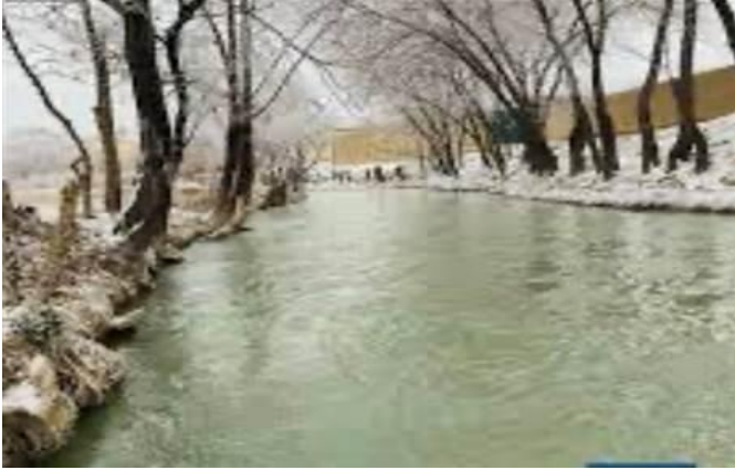
“Nəhri-Şahi” (Sultan kanalı)nın indiki görünüşü
